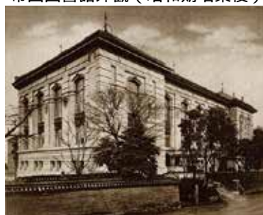
帝国図書館外観（昭和期増築後）
