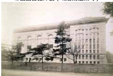
帝国図書館外観（明治期建築時）
